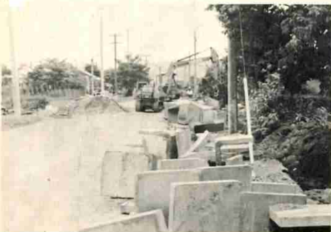
石山通りの舗装は、歩道が3.5m 両側に車道9m で工事が進んでいます。
