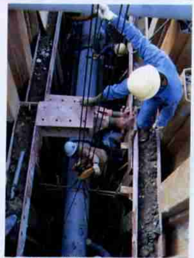
◎公共下水道事業 中央地区を中心に着々と下水道 管の埋設が進められています。
