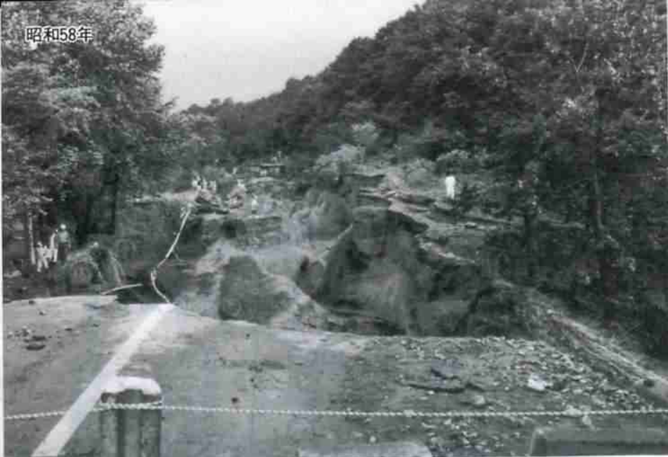
58年9月に降った雨は3時間雨量で、気象庁開設以来3位の記録を残す。写真は、寸断された道道洞爺湖登別線。
